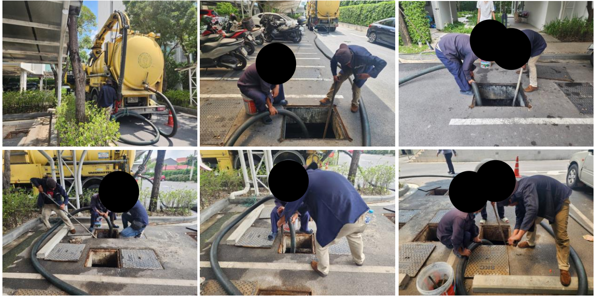
รูปที่ 2-41 สูดสิ่งปฏิกูลและดูดไขมัน เมื่อวันที่ 15 ตุลาคม 2567 ในปี 2568 มีแผนในเดือนตุลาคม
