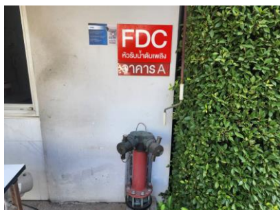
หัวรับน้ำดับเพลิงอาคาร A และอาคาร B
