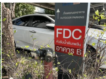
หัวรับน้ำดับเพลิงอาคาร A และอาคาร B
