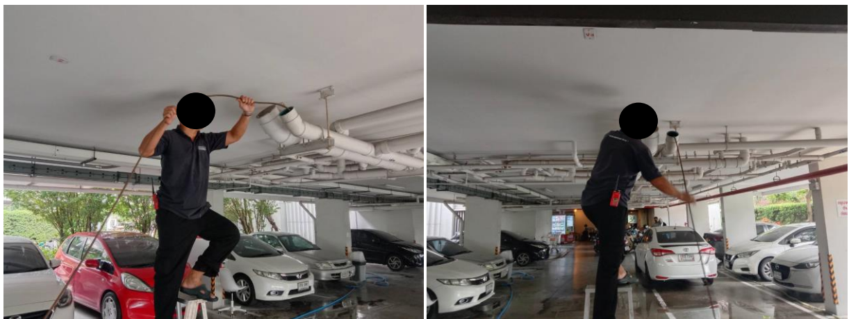
รูปที่ 2-33 ตรวจสอบและทำความสะอาดท่อระบายน้ำ
